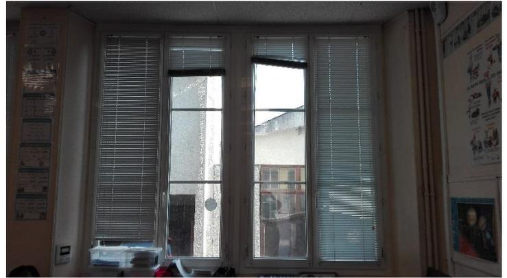
Photos des stores à lamelles dans les classes qui sont soit tous fermés soit en position ouverte du fait de la difficulté à les manipuler
